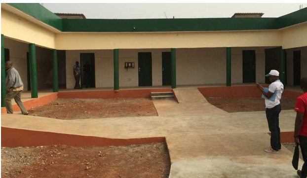
Der Bau einer großen Gesundheitsstation in einem Stadtviertel von Kpalimé in Westtogo ist abgeschlossen. 2018 soll sie eröffnet werden. (Foto: SILD, Togo)
